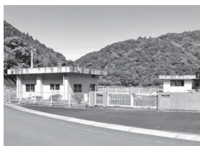
上水道上川口取水施設（上川口）
