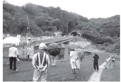
発破作業もあり、現場から遠くでの説明に（拳ノ川トンネル）
