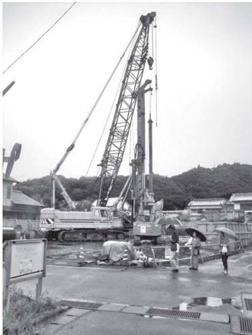
梅雨空の下、杭うち作業中の佐賀避難タワー
