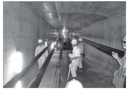
橋を守る6本のケーブル（市野瀬橋内部）
