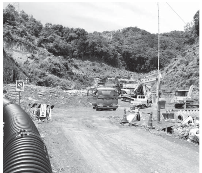
1号調整池工事の現況。作業車奥側が防災広場予定地(7月1日撮影)
