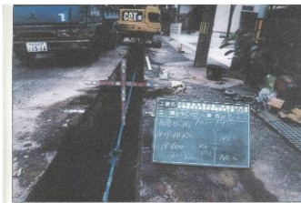
耐震管に布設替
