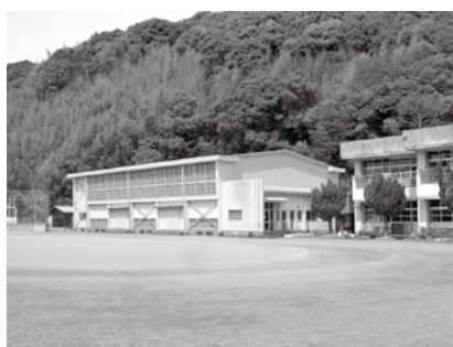
耐震工事予定の田の口小学校体育館
