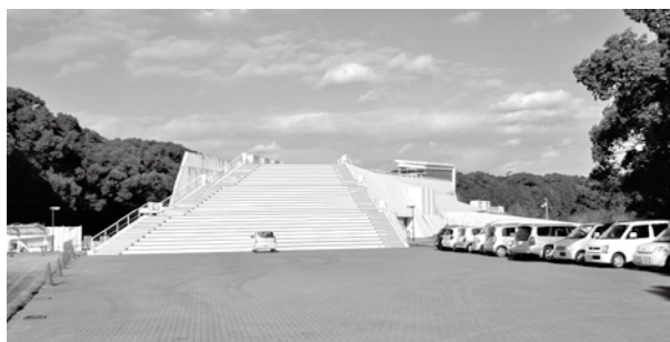
修繕の事業申請中の大方あかつき館
