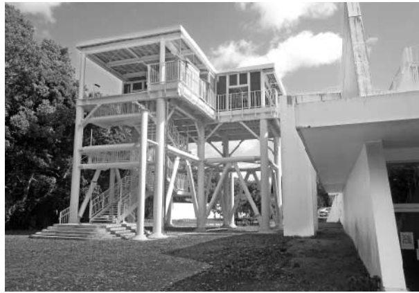
大方あかつき館敷地内に完成した津波避難タワー
